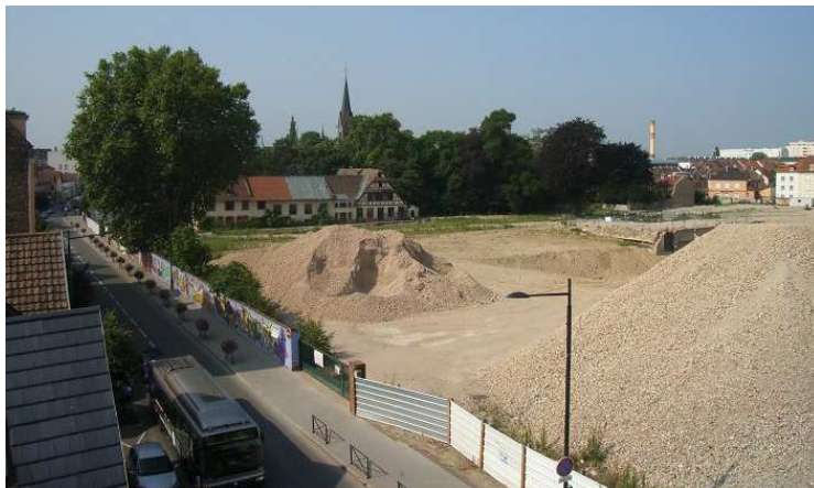
Aperçu du site Adelshoffen en phase de construction
